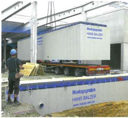
▲ Schnell eingesetzt: Die kurze Grube steht in weniger als einer halben Stunde an ihrem Platz.
