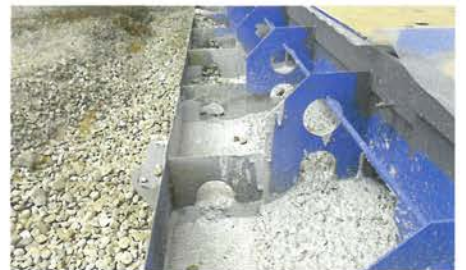
▲ Beton wird in die Füllkammern gegossen, diese leiten später die Last auf die Bodenplatte ab.
