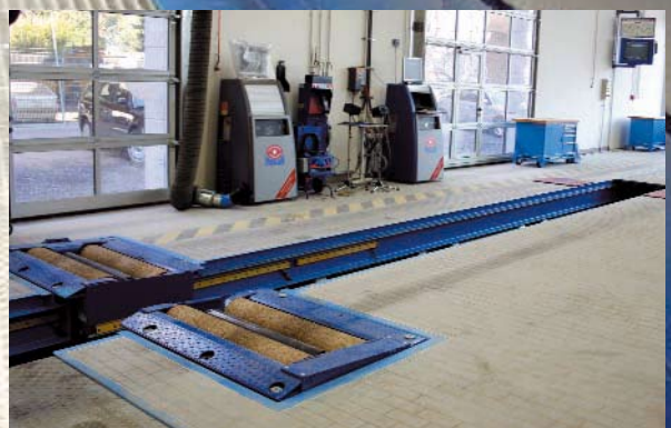
Die vorgefertigte Montagegrube eignet sich für Neubauten ebenso wie für die Nachrüstung in bestehenden Gebäude. Hintergrund: Die Innenansicht der Fertigteil-Montagegrube.
