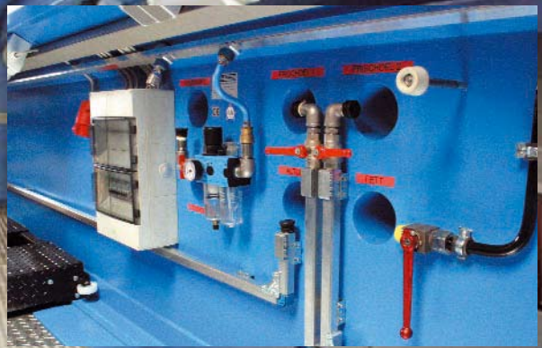
Nach Maßgabe des Auftraggebers wird die Fertigteil-Montagegrube ausgestattet.
