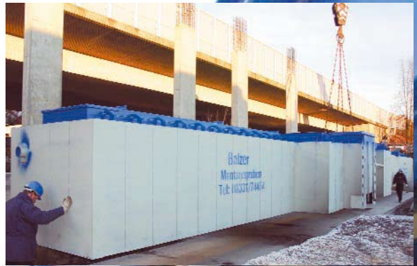
Die Fertigteil-Montagegrube aus dem Hause Balzer wird vor Ort mit einem Autokran in die Baugrube eingesetzt. Fotos: www.konzept-g.de
