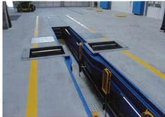
Die Prüfstrasse wird bei Nichtverwendung mit einer überfahrbaren Rollabdeckung geschlossen
