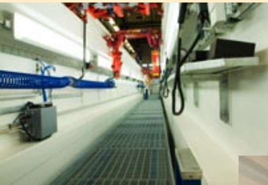
Fertigteilmontagegrube Innenansicht (oben und rechts)
