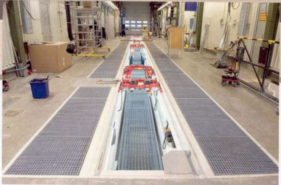
Für Schneereste geeignet: Die breiten Abwasserroste sind extrem tragfähig.
