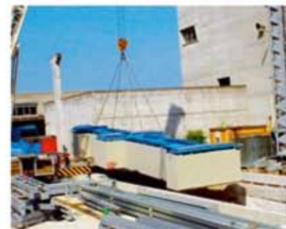
Eintellig: Der Tiefgänger liefert die 18 Meter lange, vormontierte Prüfstrasse an (oben). Dann wird die Kassette in einem Stück in der Baugrube versenkt.
